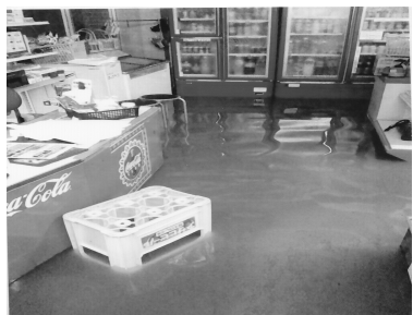
▲ 豪雨により浸水した店内
